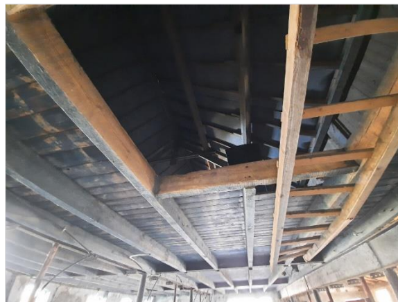
Figuur 5.11. Inkijk in één zijde van de zolder van de schuur aangelegd aan het woonhuis.
