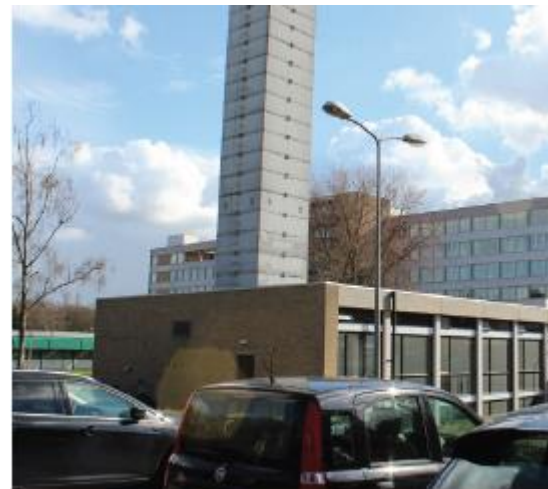
Ketelhuis met schoorsteen
