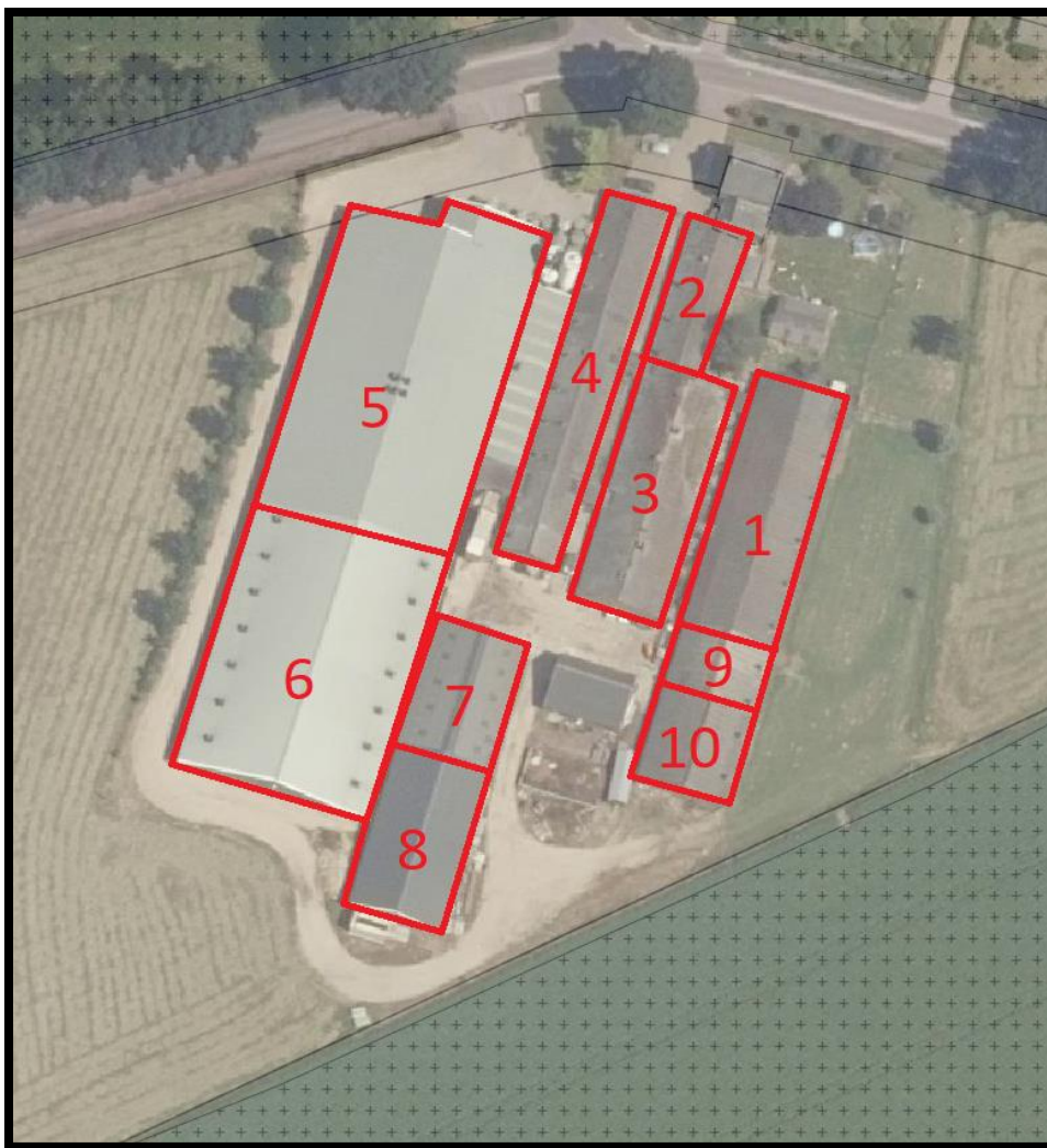
Afbeelding 2. Te slopen en te behouden stallen.
