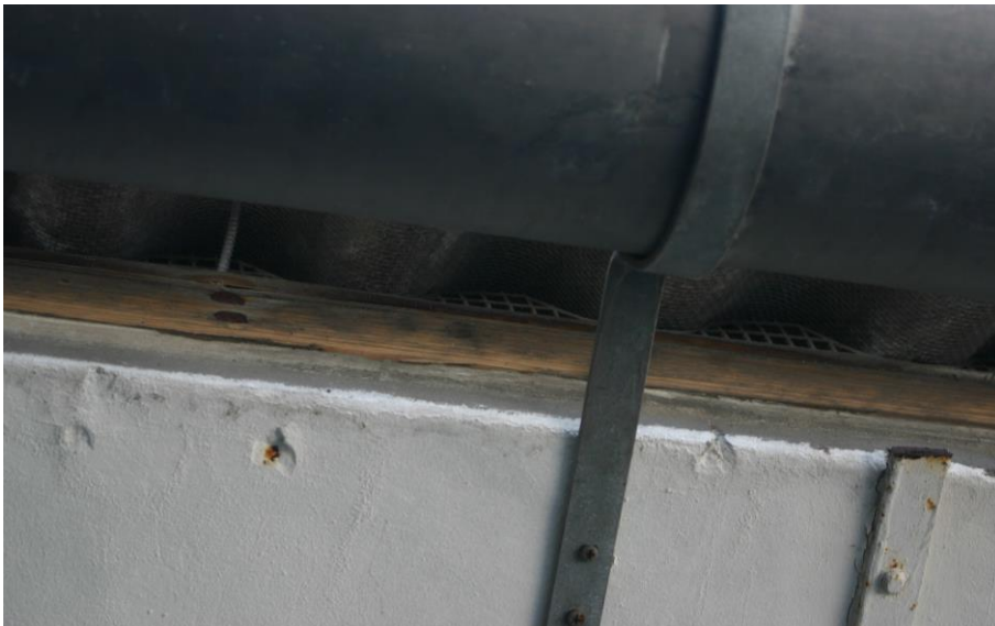
Figuur 4.4.4. Onder de golfplaten is vogelschroot aanwezig (zie figuur 4.4.4) waardoor ook hier geen vogels of vleermuizen toegang hebben
