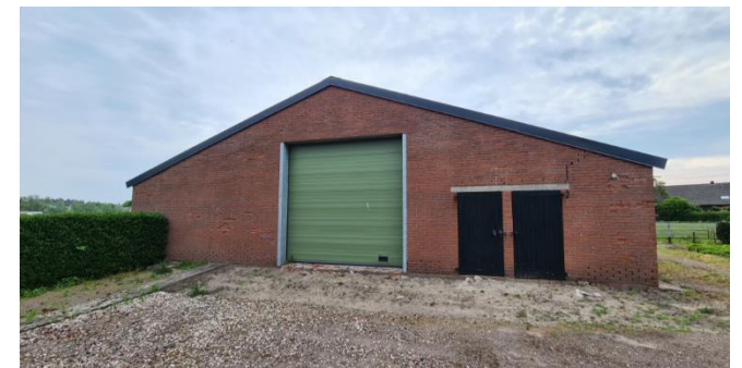
Figuur 9: Te slopen opstal in het zuidwesten van het plangebied
