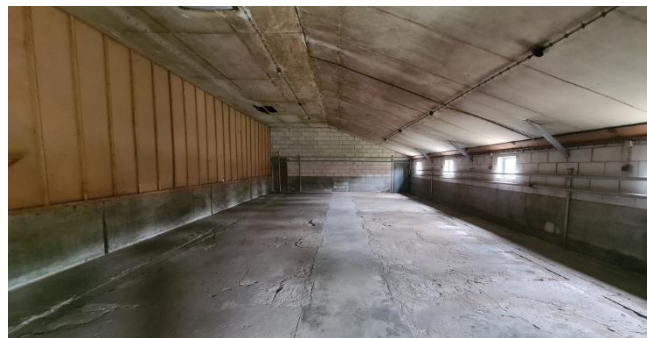
Figuur 8: Binnenkant te slopen schuur
