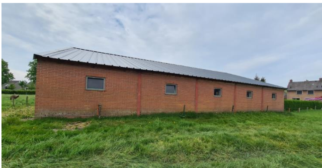
Figuur 7: Te slopen opstal in het zuidwesten van het plangebied
