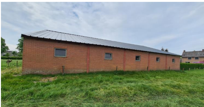
Figuur 4: Te slopen opstal in het zuidwesten van het plangebied
