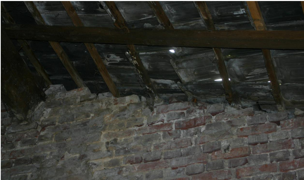
Figuur 4.2.2. De spleten tussen de dakpannen en de stenen binnenmuren zeer geschikt zijn als mogelijk vleermuisverblijf.
