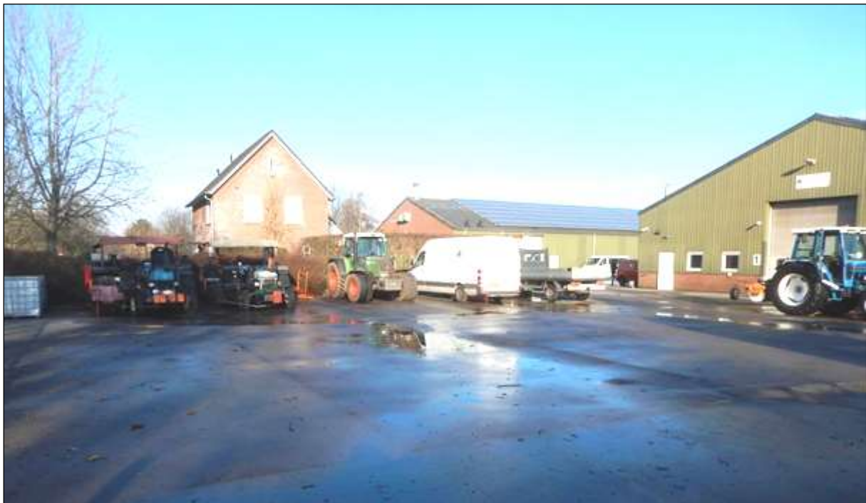
Figuur 20: Noordelijke deel van het plangebied bestaande uit bedrijfsterrein met rechts bedrijfshal uit 2004 en links woonhuis Rouwkuilenweg 9. Zicht in noordoostelijke richting.
