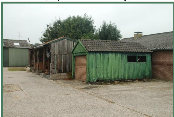
Garage met daarachter de kapschuur
