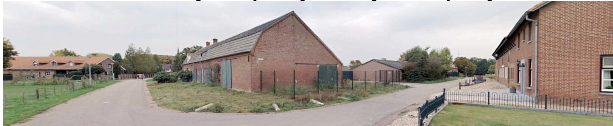
3) De nogal gesloten noordgevel en de hekwerken presenteren zich nadrukkelijk; een groen kader ontbreekt
