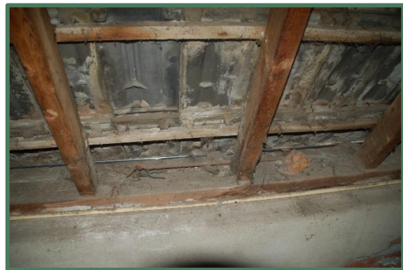
Open dak boven goot bedrijfsgebouwe
