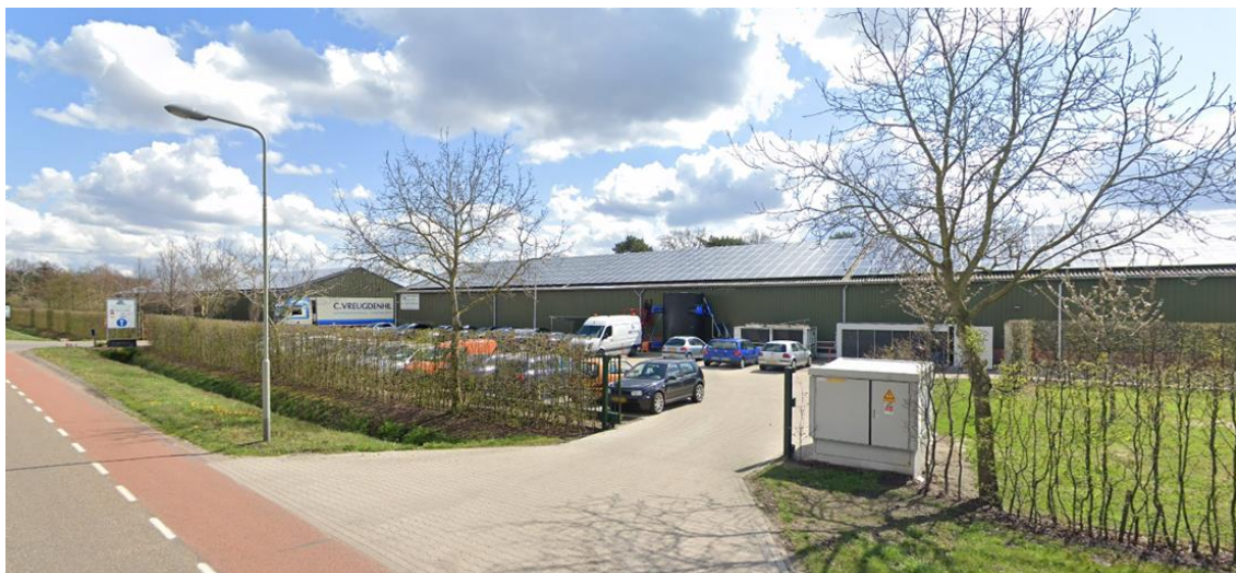
Aanzicht op de bedrijfslocatie vanaf de Ysselsteynseweg (bron: Google Streetview)
