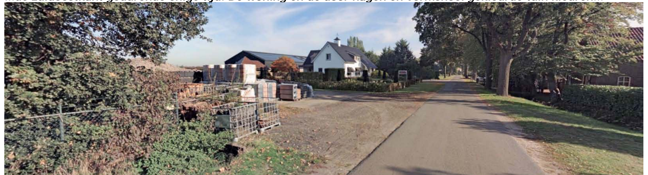
... het beeld en schermen het bedrijfsgebouw en het werkterrein af.
