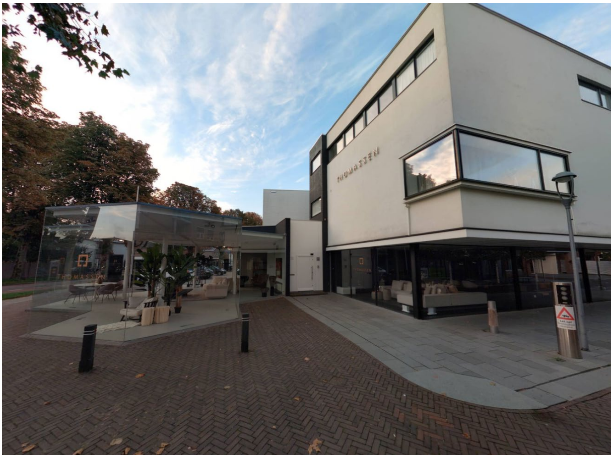
Vitrine en modernistische showroom: Een unieke architectonische kwaliteit in het centrum van Venray.
