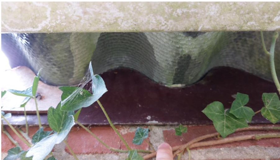
Figuur 4.2. Vogelschroot en onder de golfplaten van het schuurtje op een perceel ten westen van het plangebied.
