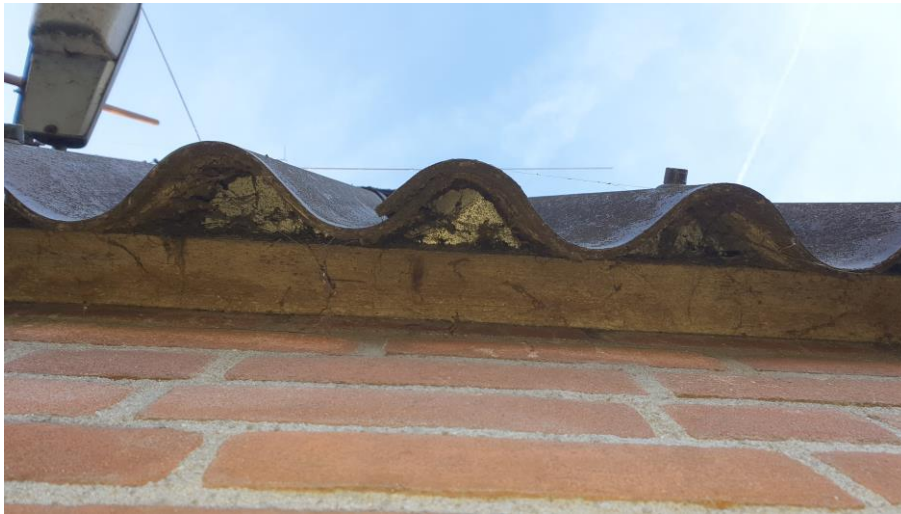
Figuur 4.4.1. Onder de golfplaten gevelbekleding is vogelschroot aanwezig. Vleermuizen kunnen hier niet onder de golfplaten kruipen.
