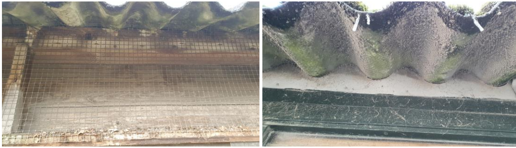
Figuur 4.4.1. Door de aanwezigheid van vogelschroot kunnen huismussen, gierzwaluwen of steenuilen de ruimte tussen het dak en dakbeschot niet bereiken.
