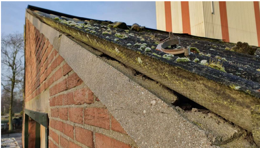
Figuur 4.4.2. Tussen de kopgevels en de golfplaten zijn kieren en spleten aanwezig waardoor vleermuizen de spouw kunnen bereiken. De meest zuidwestelijke kopgevel (hier afgebeeld) bevat de grootste spleten.
