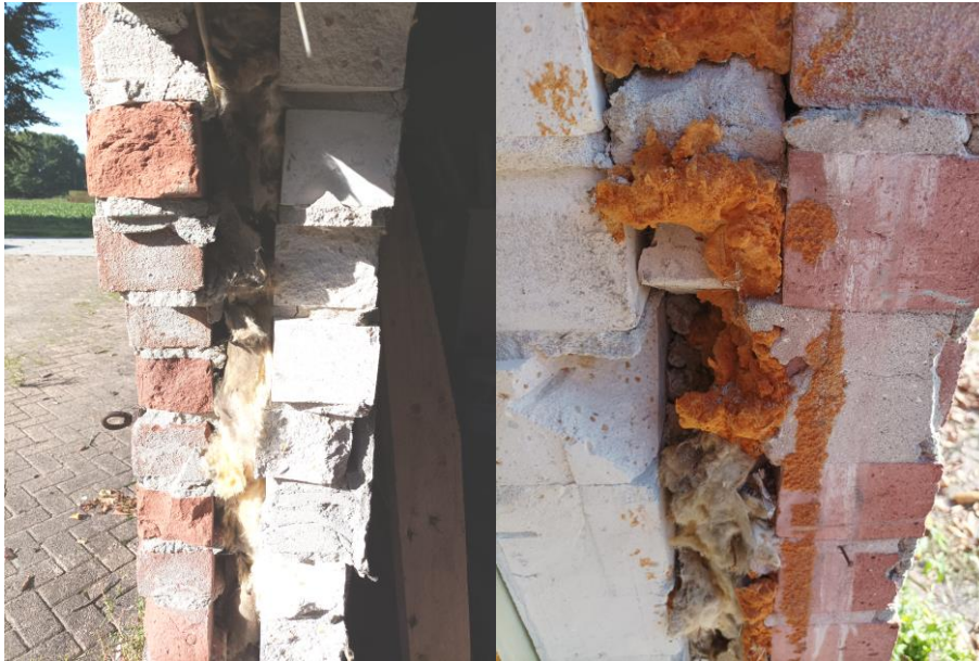
Figuur 4.2.1 De spouwmuren volledig opgevuld met isolatiemateriaal.
