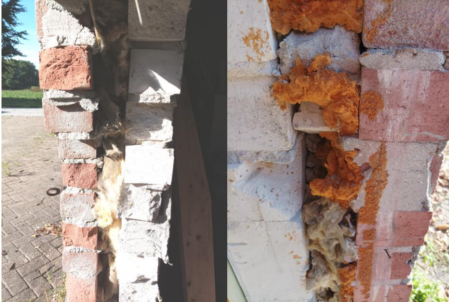
Figuur 4.2.1 De spouwmuren volledig opgevuld met isolatiemateriaal.
