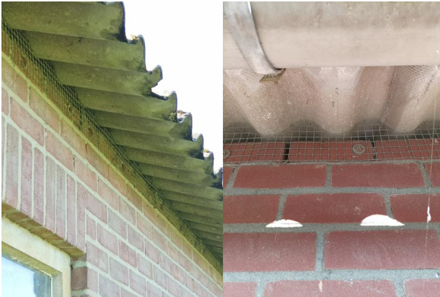
Figuur 4.4.3. De afwerking met gaas van het golfplaten dak.
