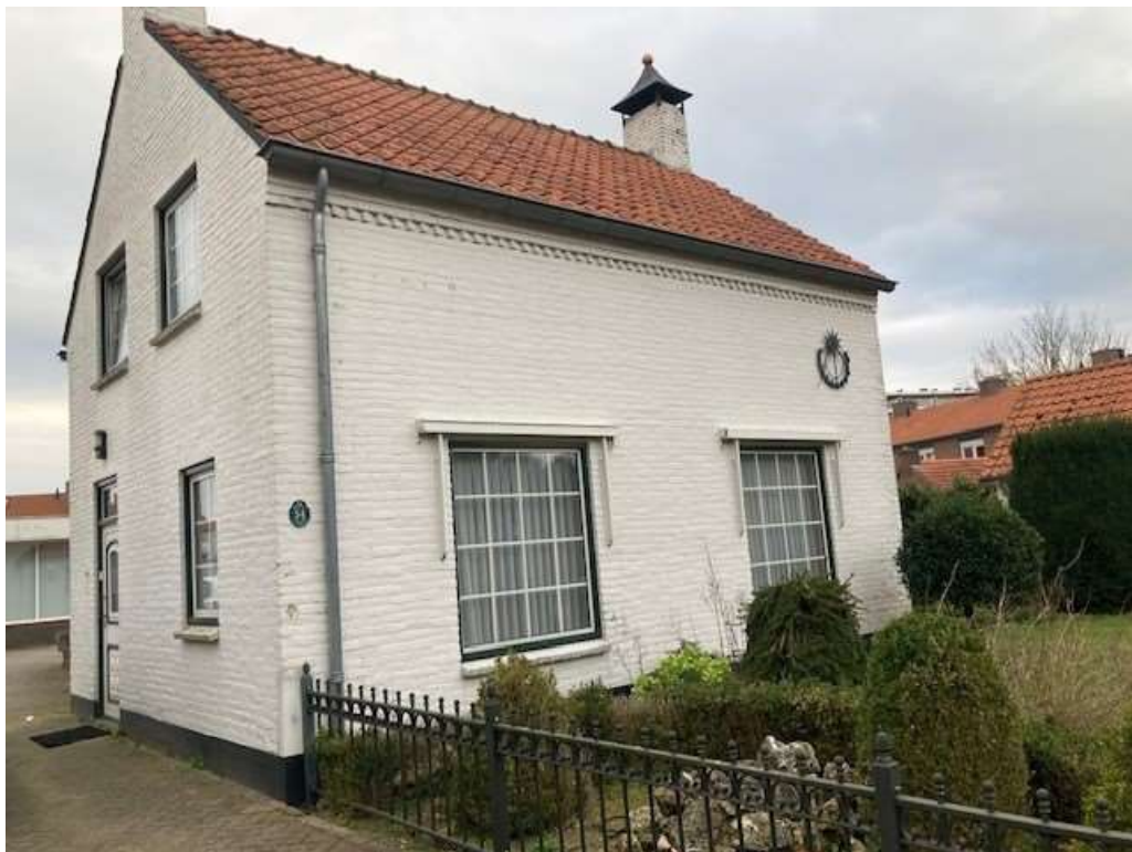
• Afbeelding 3: Voorgevel bedrijfswoning
