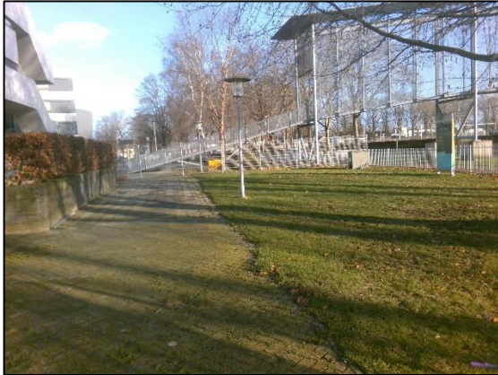
Foto 7: zuidoostzijde gebouw C (oostelijk gericht – richting loopbrug)
