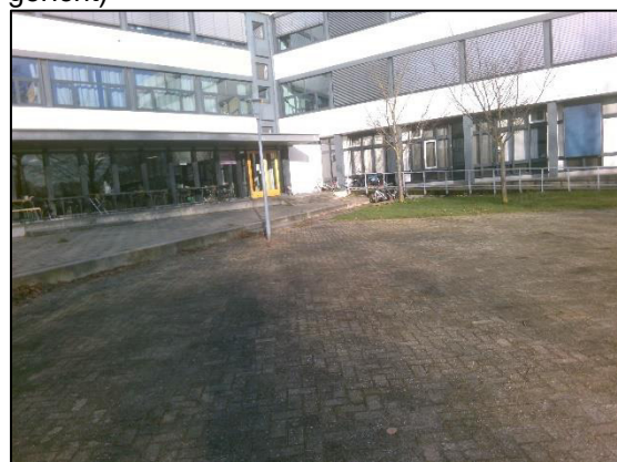
Foto 6: zuidzijde gebouw C (noordoostelijk gericht)
