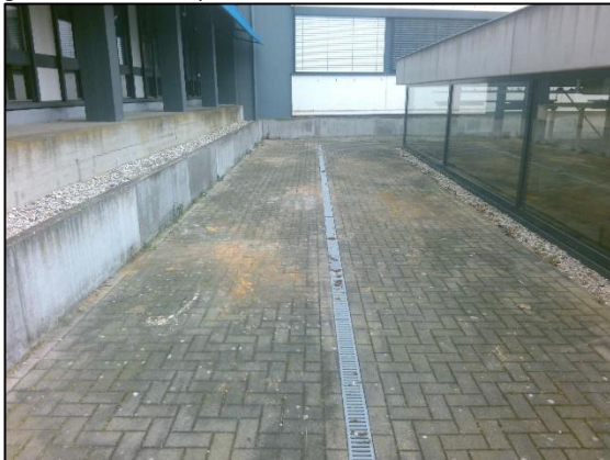
Foto 11: voormalige situering HBO-tank (tussen gebouw C en F)
