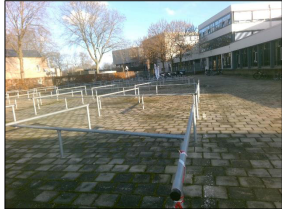
Foto 8: noordzijde gebouw C en E (voormalige fietsenstalling – oostelijk gericht)
