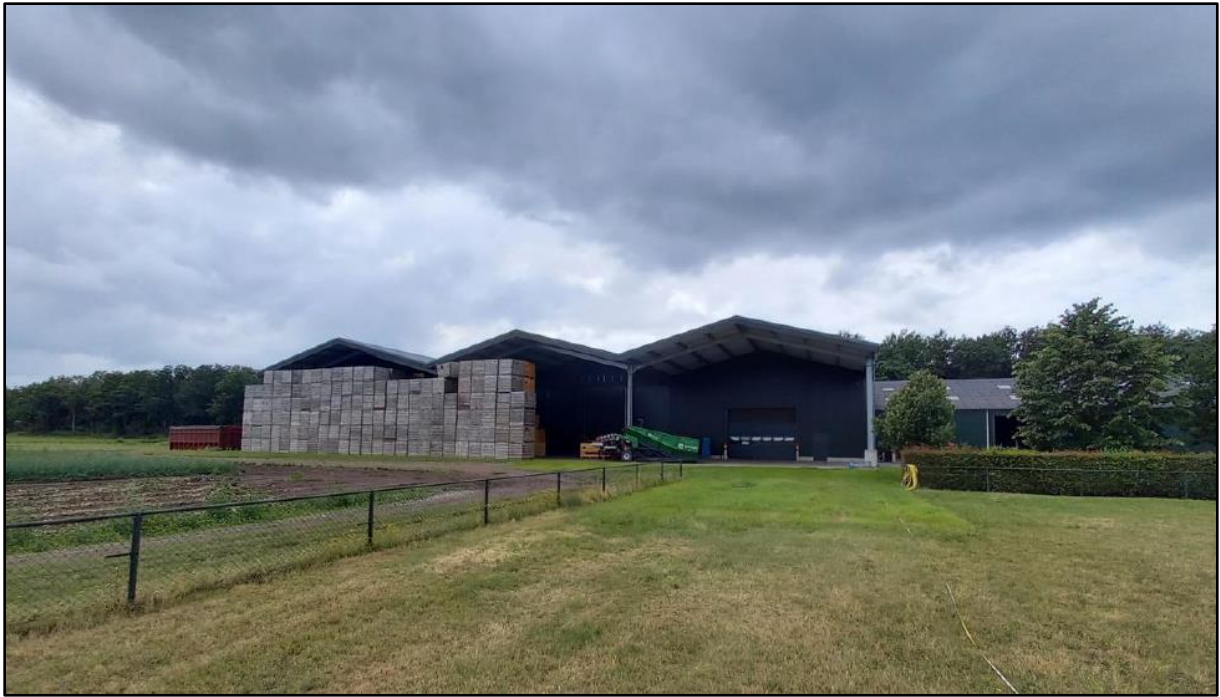
Afbeelding 5: bestaande bewaar ruimte met stalling kisten onder de luifel.
