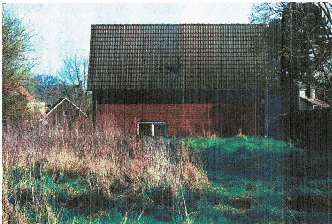
uitzicht 'bouwperceel' naar huis Beetezijweg 1b
