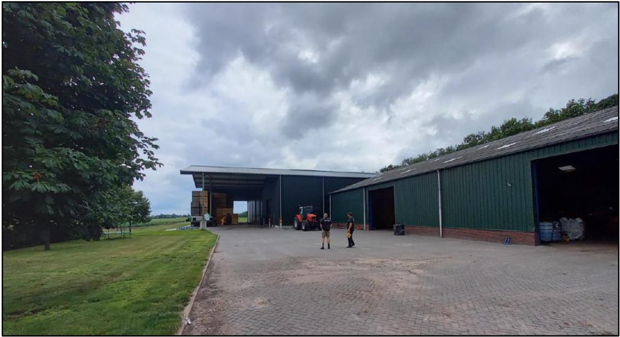
Afbeelding 7. Bestaande bebouwing gezien vanuit straatzijde.
