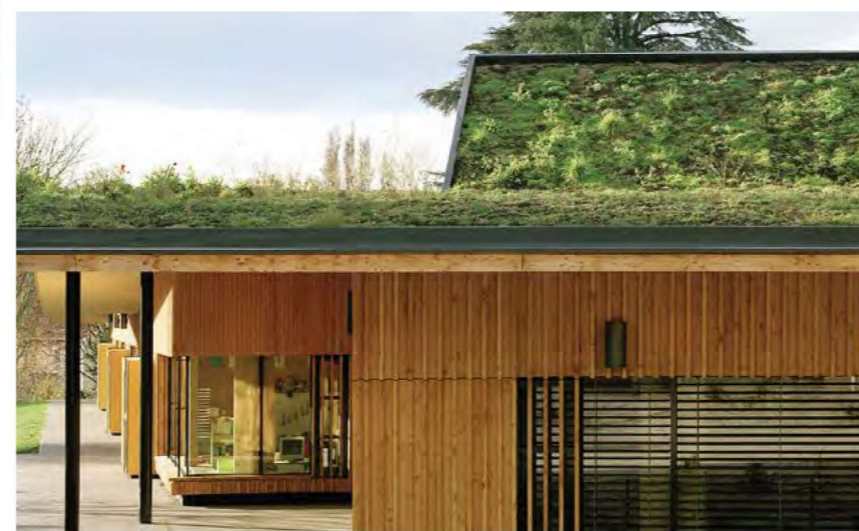
GEBOUWDELEN AFZONDERLIJK AFLEESBAAR ONDER ÉÉN GEZAMENLIJK DAK PAUL CHEVALLIER SCHOOL - RILLIEUX-LA-PAPE
