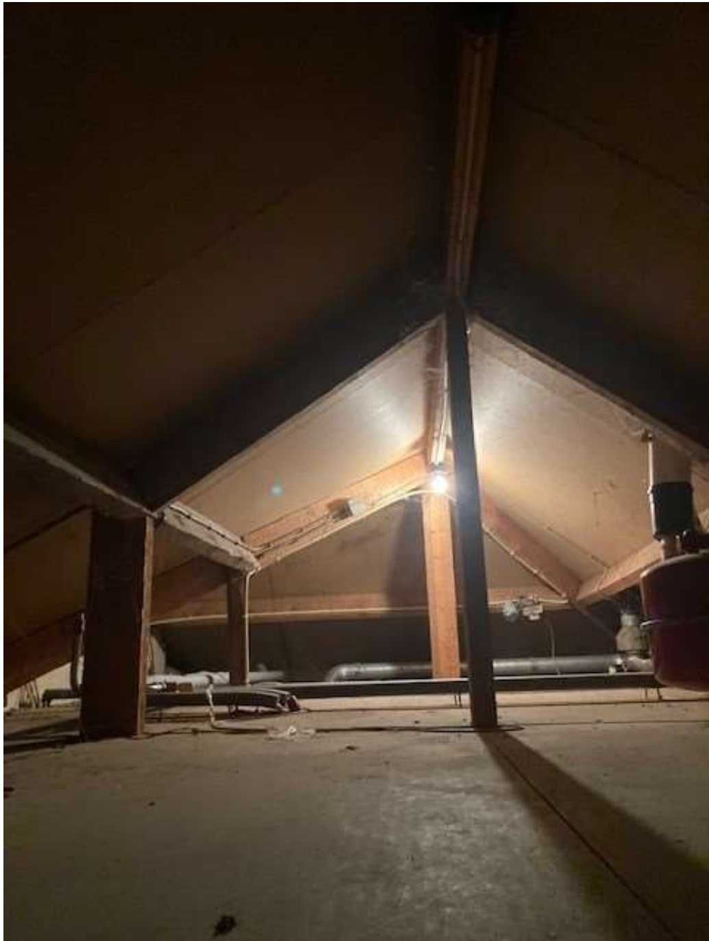
• Afbeelding 8: Zolder aangebouwd bij gebouw
