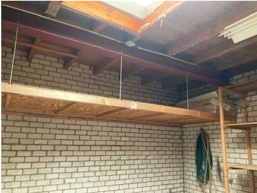
• Afbeelding 14: Binnenzijde bedrijfsgebouw
