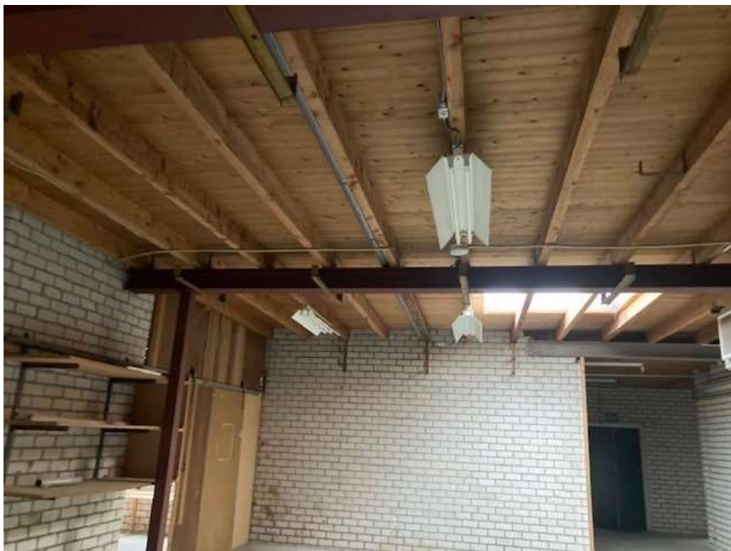
• Afbeelding 13: Binnenzijde bedrijfsgebouw
