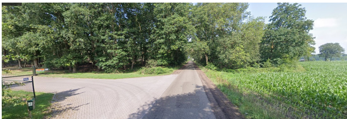
Afbeelding5: Weverslo, zicht richtingnoorden
