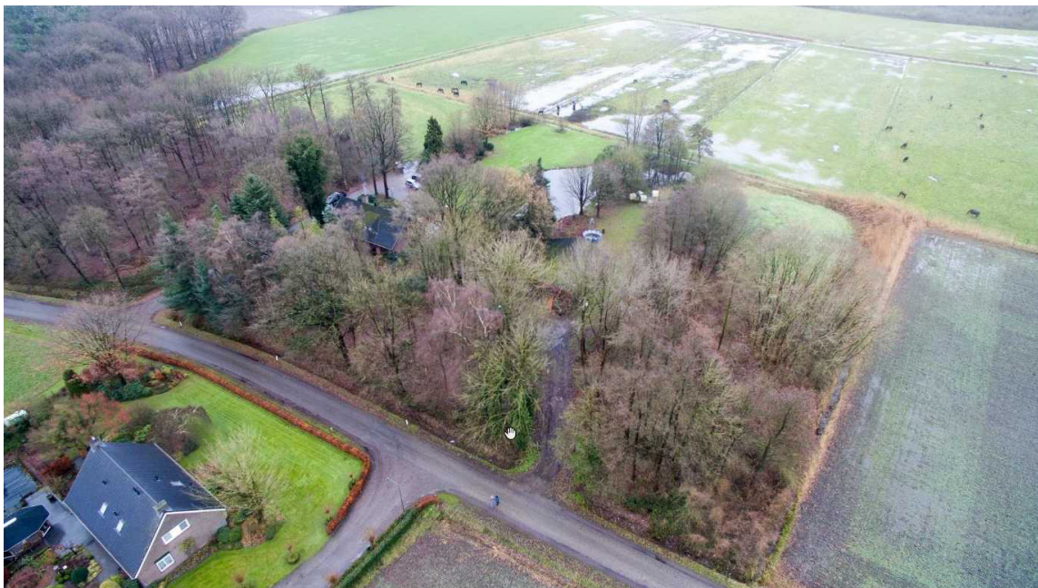
Figuur 2.3: Luchtfoto ter plaatse van huidige bebouwing aan de straat Weverslo; links 2A, rechts 2D Bron; Hof van Weverslo
