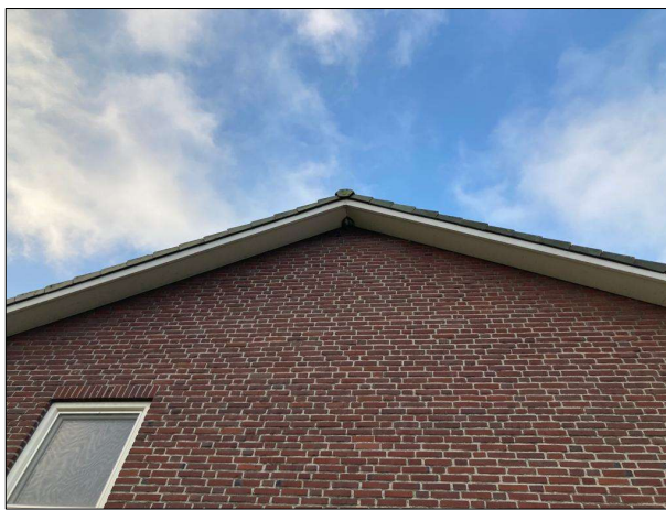
• Afbeelding 8: Nok te slopen woonhuis met huiszwaluwnest
