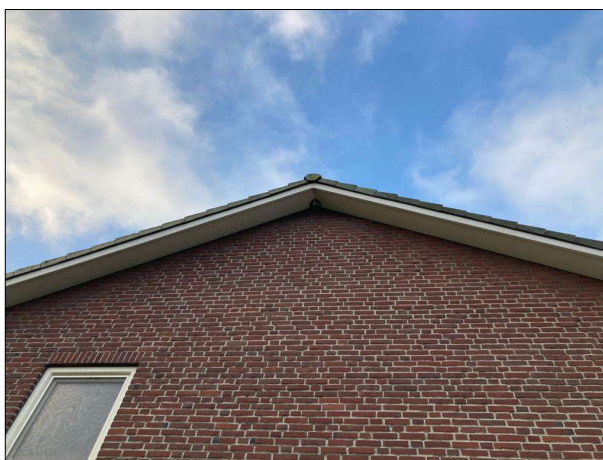
• Afbeelding 8: Nok te slopen woonhuis met huiszwaluwnest
