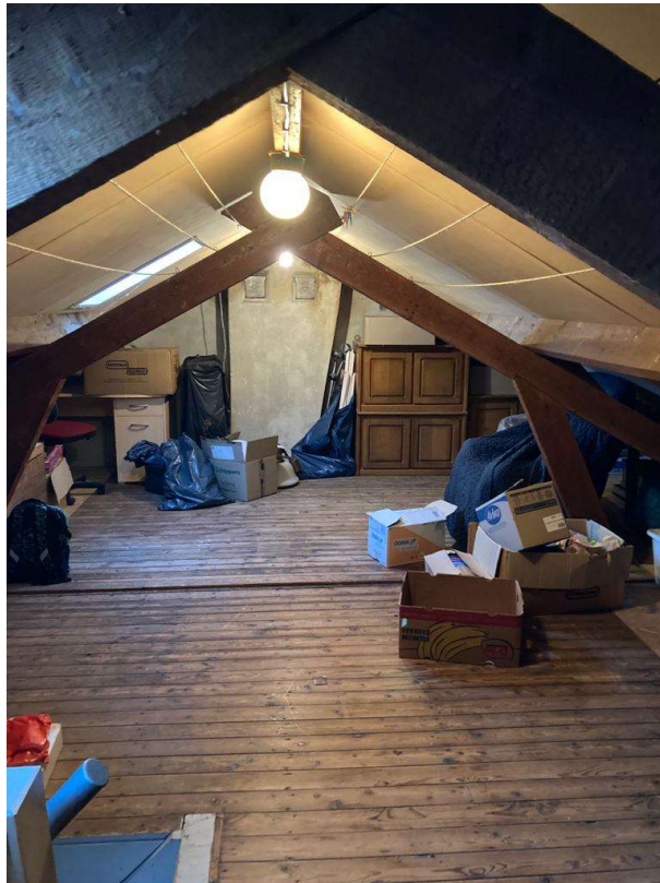
• Afbeelding 5: Zolder te slopen woonhuis
