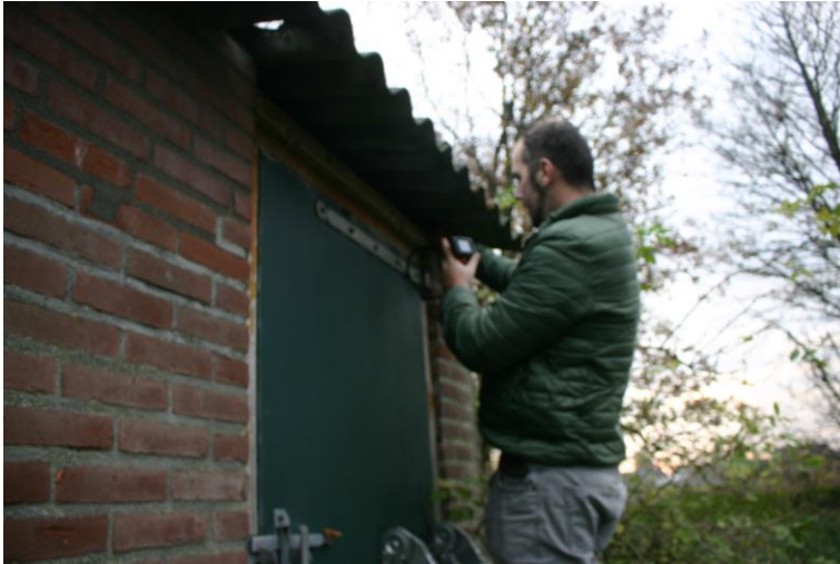
Figuur 4.2.3. Tijdens de inspectie van de ruimtes onder de golfplaten met een boomcamera werden er twee kauwennesten waargenomen.
