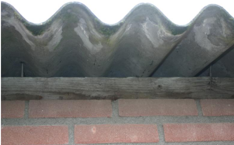
Figuur 4.2.2. Op enkele plekken waar nog isolatieplaten onder het plafond aanwezig zijn, is de ruimte onder de ‘golven’ open. De spouw is afgedicht met een muurplaat.
