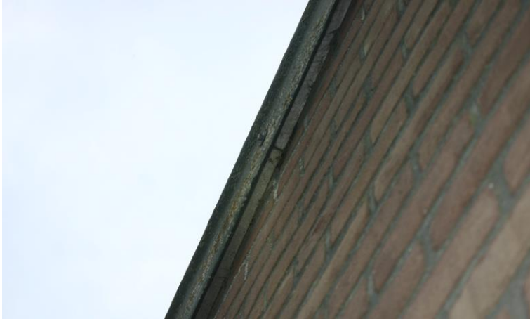
Figuur 4.2.1. De golfplaten op de kopse kanten van stal 1 zijn bevestigd op een nauw op de gevel aansluitende plaat.
