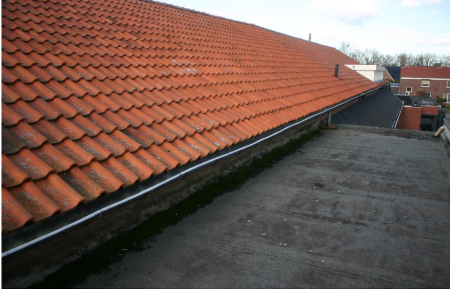
Figuur 4.4.3. Voor vleermuizen en gierzwaluwen is er geen geschikte aanvliegroute doordat de dakpannen zich erg dicht bij het onderliggende dak bevinden.
