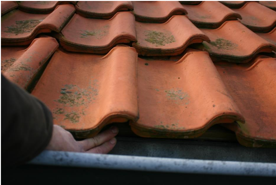
Figuur 4.4.2. Huismussen hebben geen toegang tot het dak door een te kleine opening onder de dakpannen.
