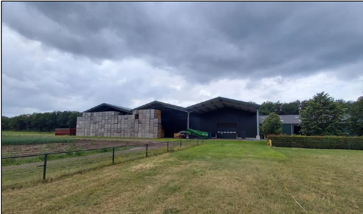
Afbeelding 6. Bestaande bewaar ruimte gezien van oostzijde met opslag kisten onder de luifel.
