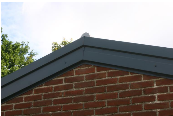
Figuur 4.2.3. Het dak van de garage met aluminium dakafwerking.
