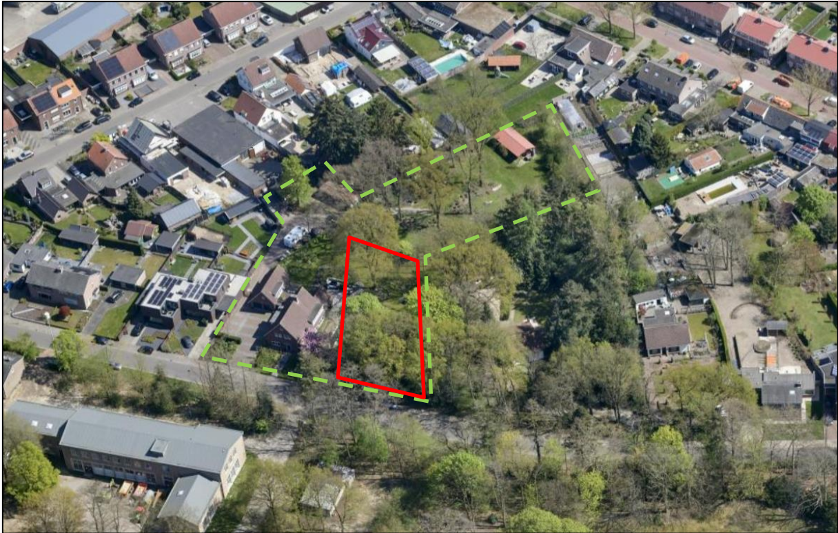
Afbeelding 4 Luchtfoto (rood; plangebied, groen; huidig woonperceel Dr. Kortmannweg 16)
