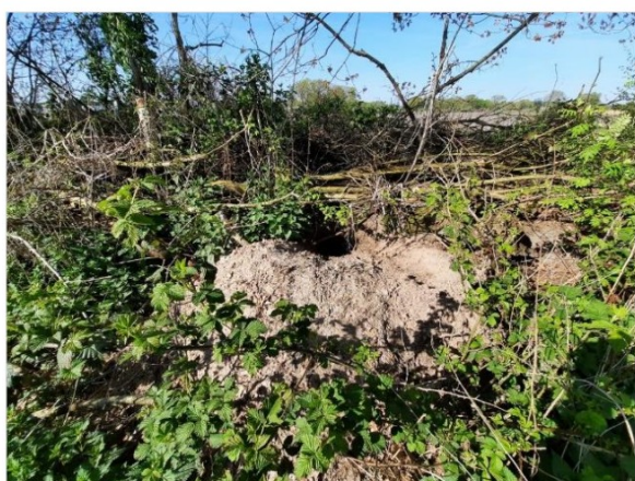
Figuur 5.12. Voorbeeld van één van de dassenpijpen in houtwal.
