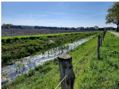
Figuur 2.9. Impressie van sloot ten oosten van weg Venraysbroek.
