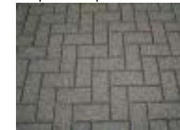
bestrating loopstrook toegangsweg en ringweg
