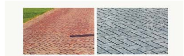
bestrating rijbaan en loopstrook plein
