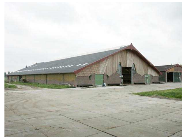
Typische gevelindeling en dakoverstek maar op zorgvuldige manier uitgevoerd.
