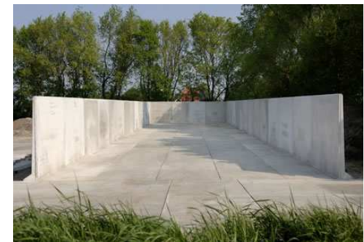
Deze betonnen sleufsilos ligt dicht aan de weg en is aan de voorzijde zeer prominent in het zicht en niet ingepast.
