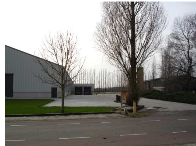
De brede verharding zonder afscherming van een haag zorgt voor een hard, steenachtig en industrieel karakter en past niet in het buitengebied.
