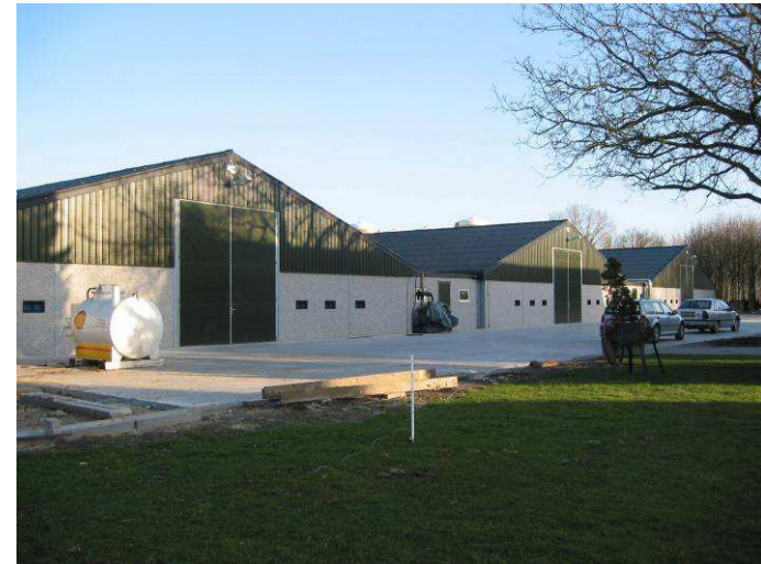
De tussenliggende bijgebouwen hebben een plat dak lager dan de goothoogte en liggen iets terug en sluiten daardoor aan op de hoofdmassa's.
