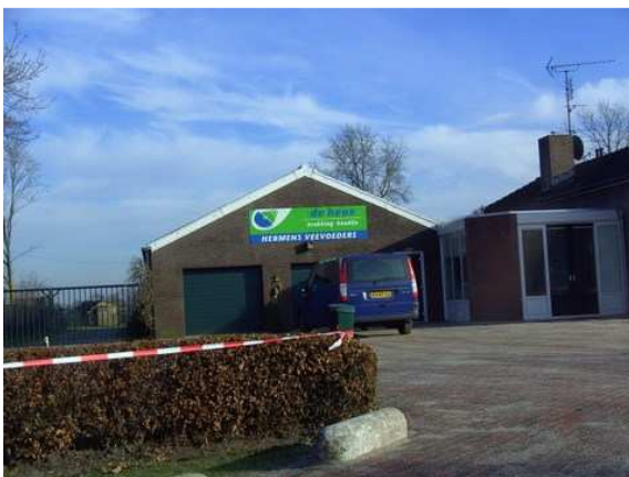
Reclame aangebracht aan de gevel van het gebouw die te fel van kleur en te groot van omvang is.
