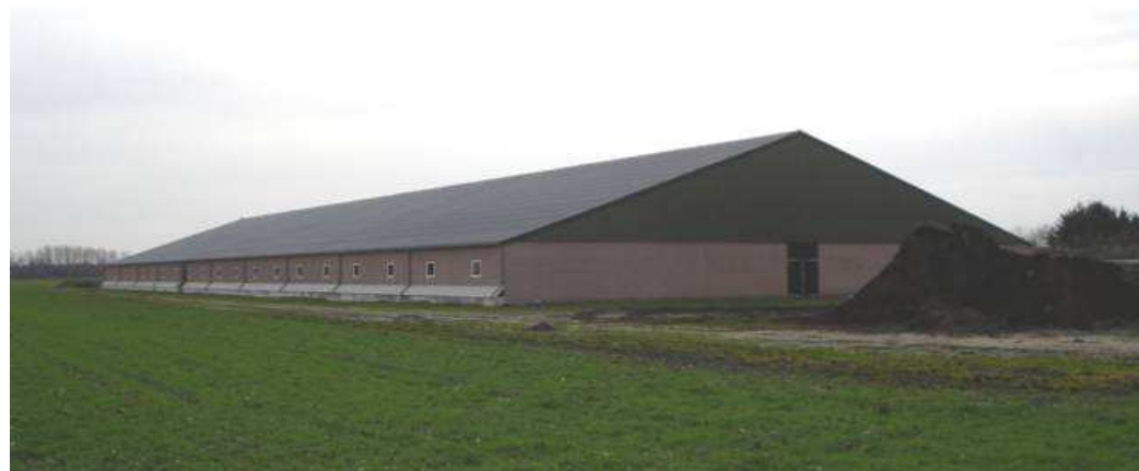
Deze stal heeft een lage goothoogte en een forse kap. De kopgevel is boven de goothoogte van een ander materiaal.
