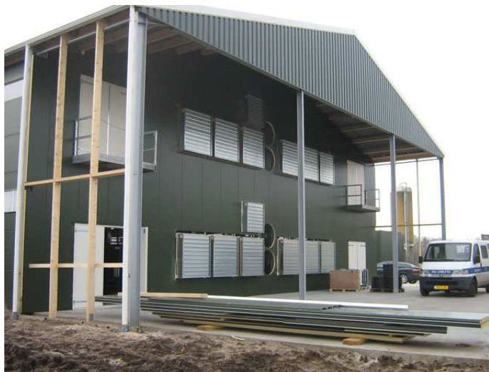
Dit bedrijfsgebouw staat ver af van de oorspronkelijk agrarische stal en heeft een erg industrieel karakter.
