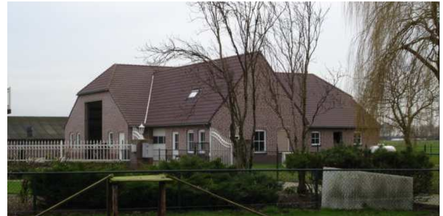
Complexe schakeling van bouwmassa's . Herkenbaarheid van boerderijtype is verdwenen.
