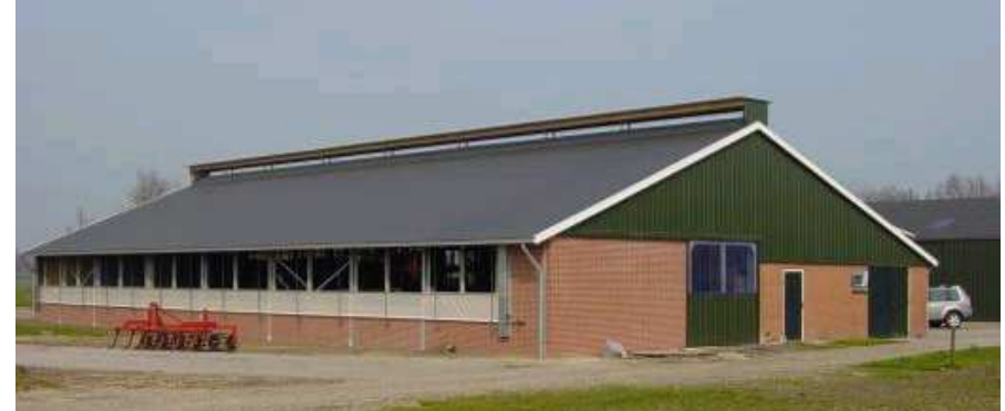
Een lucht afvoer in de nok kan minder opvallend zijn dan vele grote afvoeren die het dakvlak teveel onderbreken.
