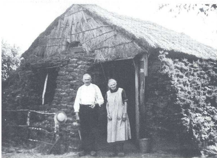
In dit van turf en plaggen opgetrokken huisje woonde het gezin van gemeentewerker ("wegkretser") Frans Nooyen van 1921 t/m 1938.
