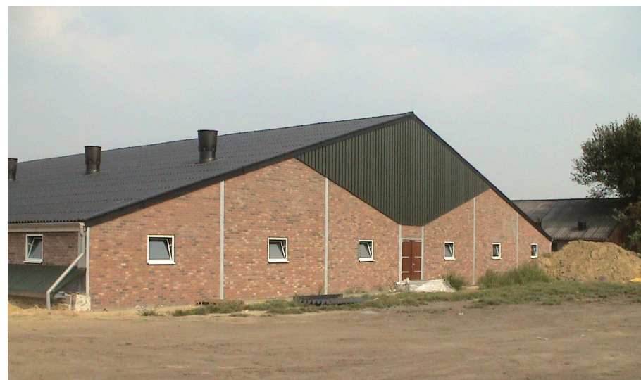
Deze stal heeft een zorgvuldige gevelindeling en kleur –en materiaalgebruik.
