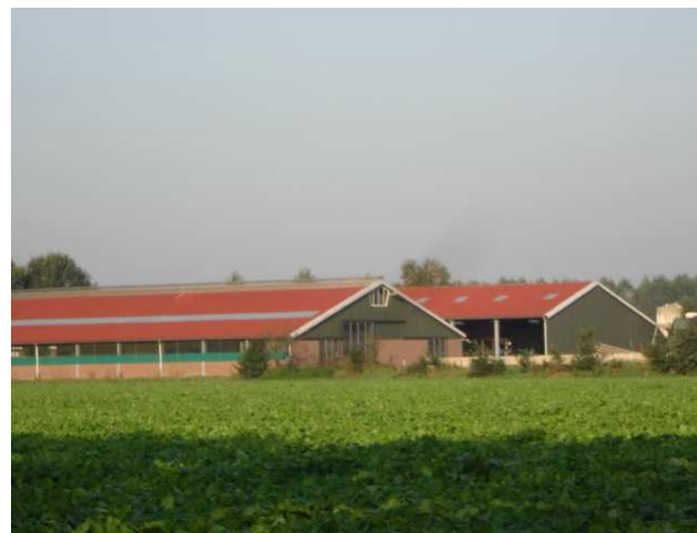
Grootschalige bebouwing in het beekdal vraagt om een forsere inpassing in het beekdal. Deze gebouwen zijn te prominent aanwezig.
