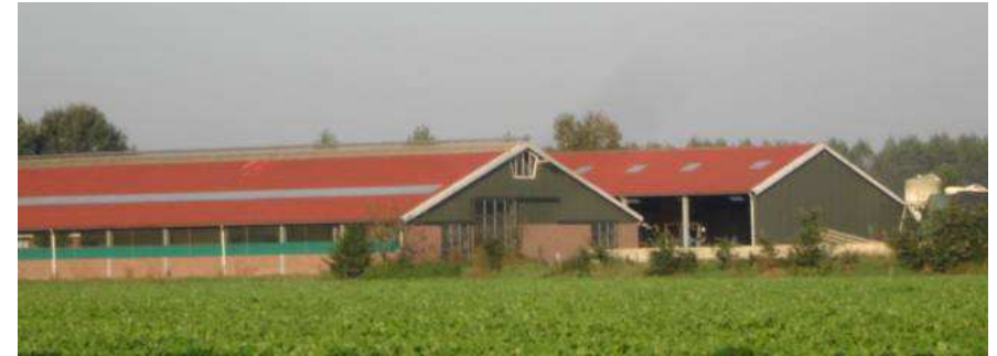
De rode daken vallen op maar hebben toch een natuurlijke kleur. De witte windveren zorgen voor een duidelijk onderscheid tussen kopgevel en dak. In bepaalde gevallen kan dat een mogelijkheid zijn.
